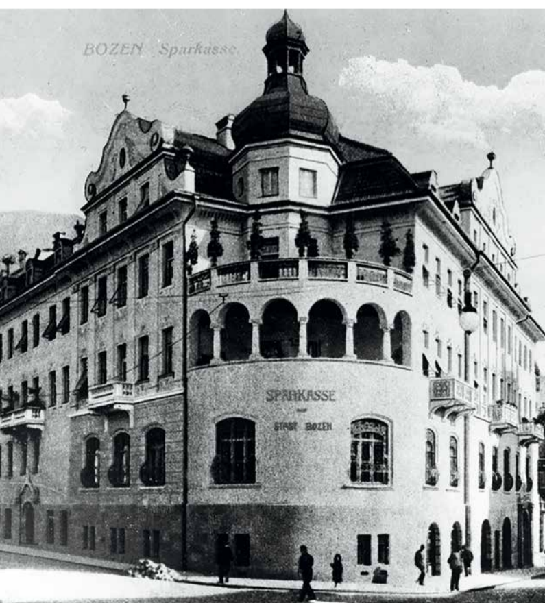
Der neue Sitz der Sparkasse, der im Jahr 1907 fertiggestellt wurde.
